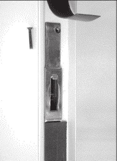
**10** Visser la serrure (vis M6) et refixer le joint intumescent FC, ajoutant si nécessaire 2 gouttes de silicone.
