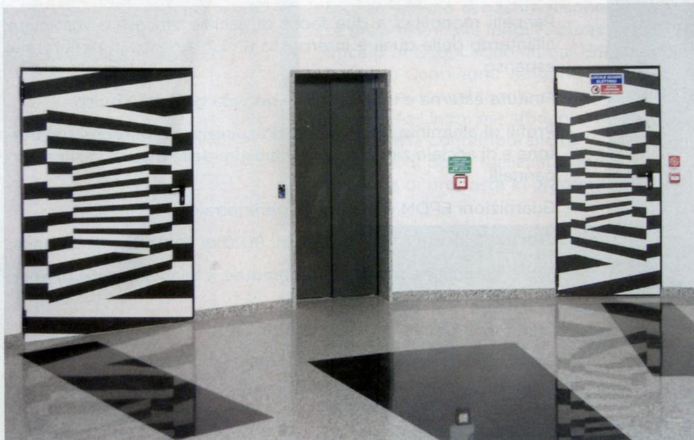
Le porte tagliafuoco NINZ sono interamente prodotte in lamiera zincata; le rappresentazioni grafiche sono eseguite a mezzo di verniciatura direttamente sull'anta con polveri epossipoliestere termoindurite
