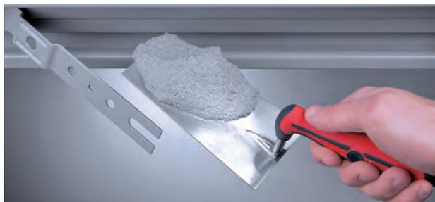
En cas de fixation avec les pattes de fixation, il est conseillé de créer des entailles dans le support (section 80 x 200 mm). Les pattes de fixation doivent être pliées et bloquées dans le mur. Pour une bonne résistance au feu et une bonne tenue mécanique, le vide entre dormant et mur doit être rempli de ciment mortier.
