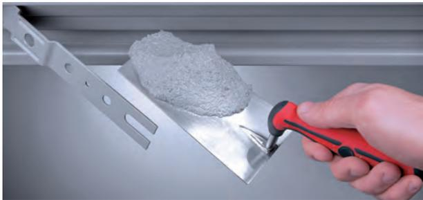
En cas de fixation avec les pattes de fixation, il est conseillé de créer des entailles dans le support (section 80 x 200 mm), ou de fixer les pattes avec des chevilles. Les pattes de fixation doivent être pliées et bloquées dans le mur. Pour une bonne tenue mécanique, le vide entre dormant et mur doit être rempli de ciment mortier ou de mousse polyuréthane; par contre, ce remplissage est obligatoire en cas de porte pour extérieur marqué **CE**.
